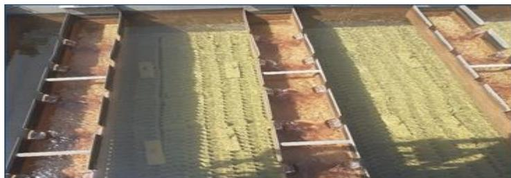
**Figure 12:** Photo de clarificateur lamellaires(AQS 2023)
